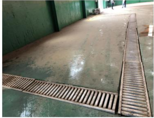
危废预处理车间地面
