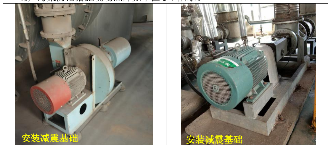
图 3-8 噪声污染防治措施现场照片
